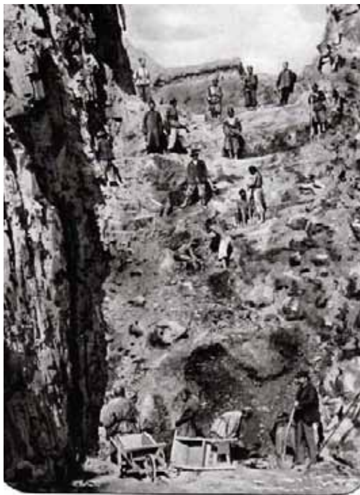
Chantiers de la tranchée du Km. 416,4.
